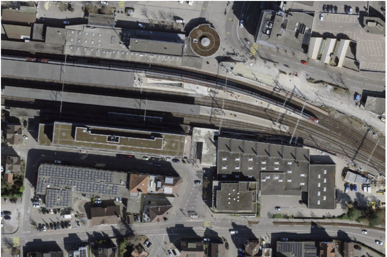
Abbildung 36: Übersicht Rodungen (Quelle: Orthofoto Geoportal SG)
