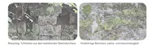
Recycling Tuffsteinen aus dem bestehenden Dammdurchlass Grobkörnige Betonhaut: patina- und bewuchstauglich
